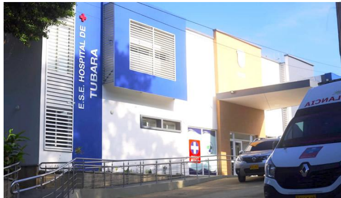
Figura 60. E.S.E Hospital de Tubará
